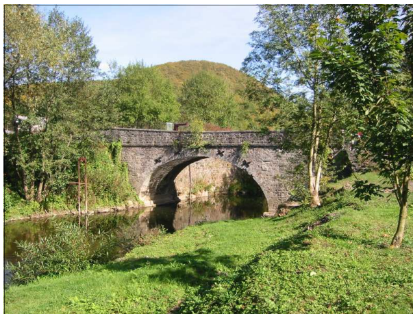
Le Viroin au niveau du remarquable pont de pierre.
