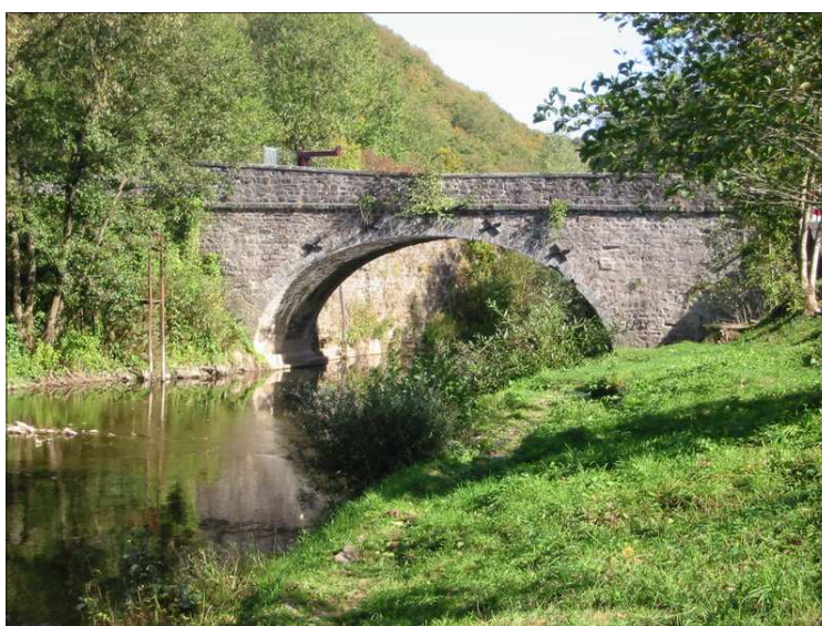
Pont de pierre à voûte surbaissée franchissant le Viroin.
