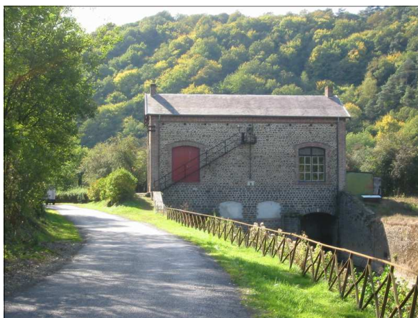
Ancienne usine électrique.
