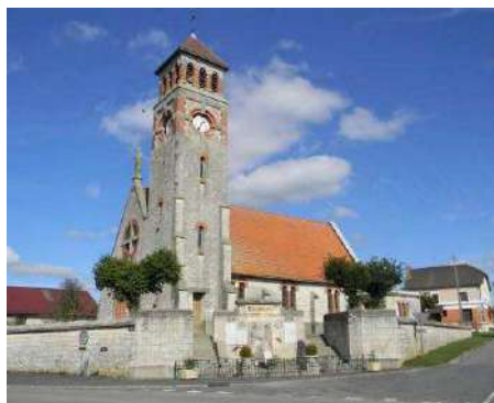
Église (non classée MH) de Terron-sur-Aisne Même si la menace n'est pas immédiate, les élus sont préoccupés par la vétusté de l'édifice, qui selon eux risque de s'effondrer d'ici une quinzaine d'années si des rénovations ne sont pas entreprises rapidement.
