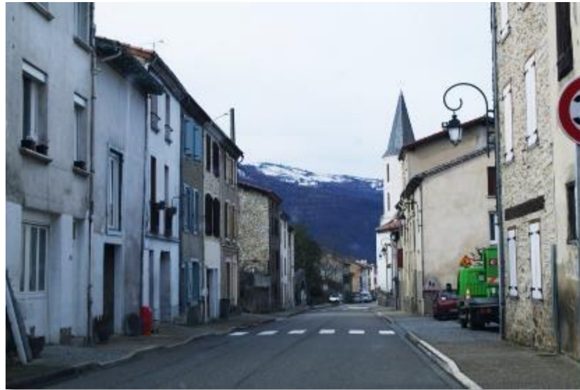
Vue du bourg originel de SAINT-PAUL-DE-JARRAT depuis la RD309A – Cadrage des perspectives par un tissu bâti dense et front à l'alignement. Espace public qualitatif avec prise en compte de l'ensemble des usagers (itinéraires, mobiliers).
