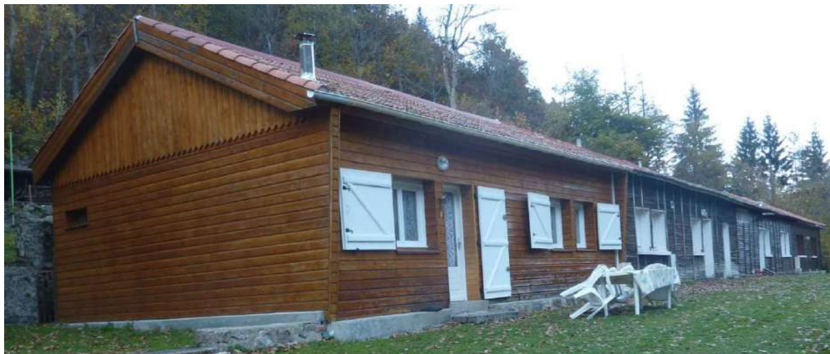
Gîtes au Nid d'aigle, la typologie se rapproche de la maison (volume plus grand, parement bois, menuiserie bois, toiture deux pans à pentes couverte en tuiles plates de teinte rouge)
