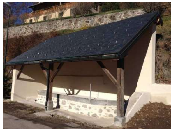
Lavoir rénové avec les codes locaux (bois, pierre, ardoise)
