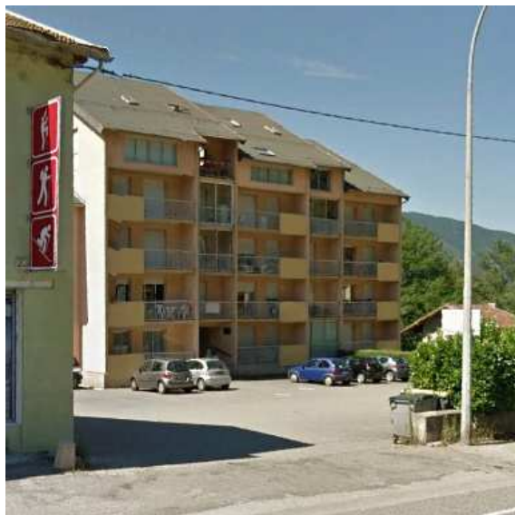
Résidence des Pyrénées, absence des codes anciens hormis la toiture plate de teinte brune. Hauteur : 5.5 niveaux.
