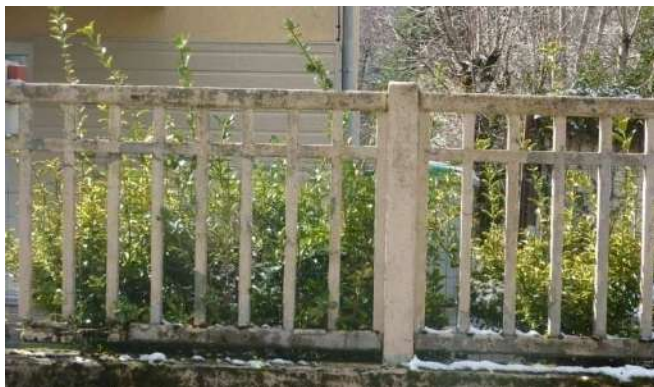
Exemple de clôture de type urbain, piquets bétons sur mur bahut, doublé d'un grillage vert. A noter le parement PVC en rez de chaussée.
