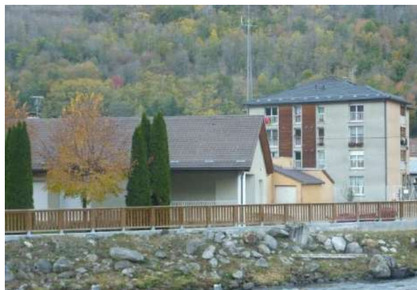
Photo de la digue à proximité de la salle des fêtes
