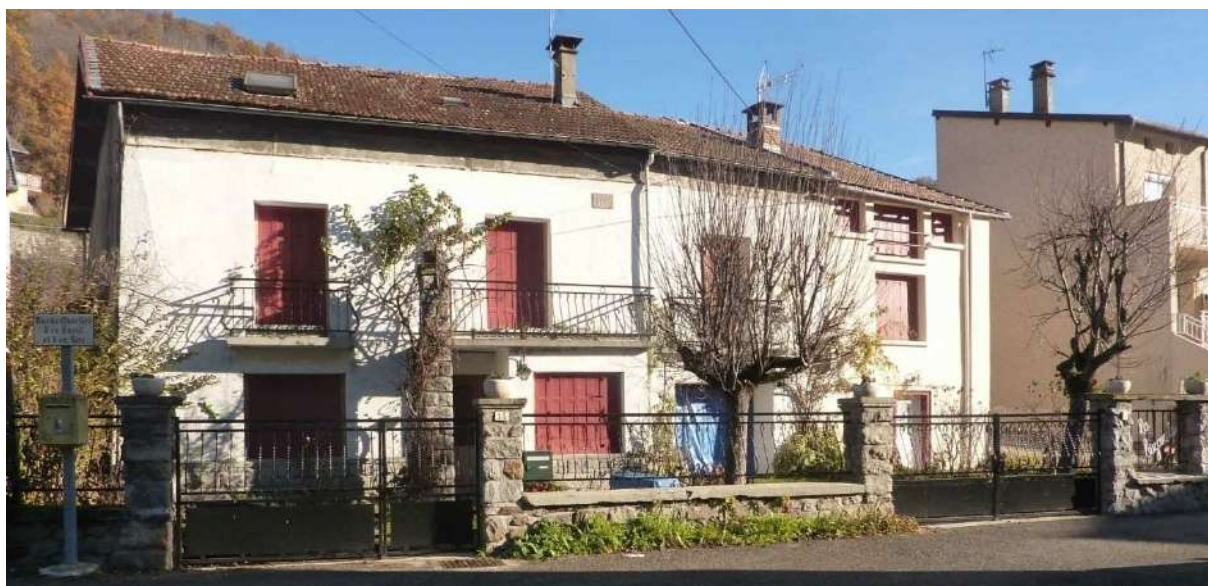
Exemple de clôture de type urbain, grille sur mur bahut
