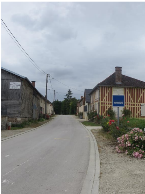
Construction à l'alignement
