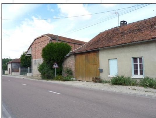
Implantations typiques des constructions anciennes
