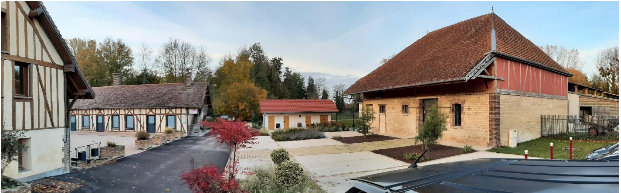
Le Cercle de la Fermette (à droite) et bâtiments municipaux / salles polyvalentes (à gauche)
