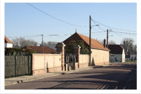
Vue sur l'exploitation depuis la rue Sadi Carnot
