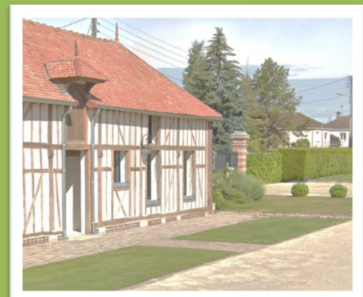
Vue sur les bâtiments internes depuis la rue Emile Buck
