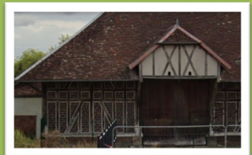
Hangar en structure bois sur la partie Sud du corps de ferme
