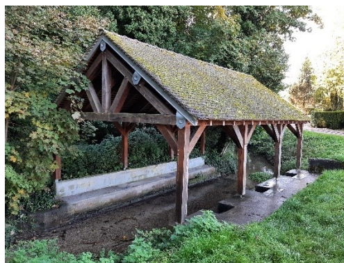
Lavoir restauré en 2013 Rue Victor Hugo
