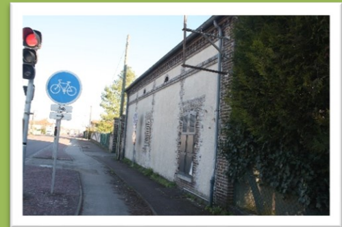
Vue piétonne de la construction depuis l'avenue du Général Leclerc
