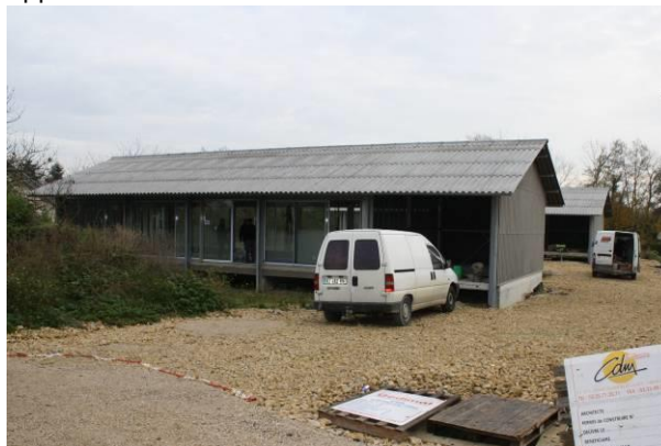
Maison en construction – structure métallique et toiture ondulé en fibre-ciment
