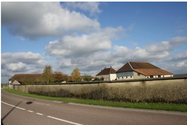
Corps de ferme – grand volume – toiture tuile
