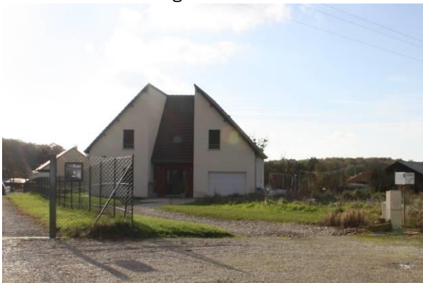
Maison récente – plusieurs toits à 1 pente en ardoise
