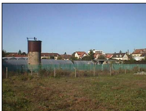
L'ancien château d'eau Chemin des Godots
