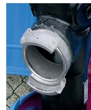
Poteau d'aspiration de 100 mm, muni d'une sortie de 100 mm,
