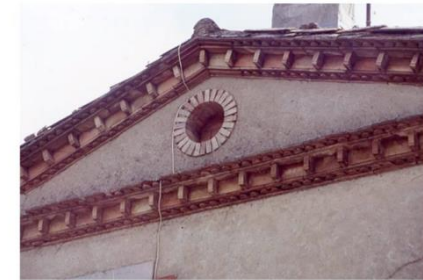
Pignon souligné par une frise en terre cuite (20, avenue de Malbec)
