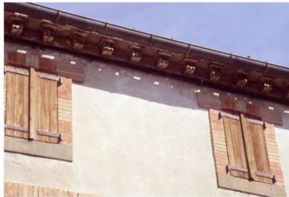
Corniche de toiture réalisée en briques cuites perforées (6, rue des Monts Lauriers)
