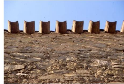
Dépassée des tuiles courantes (1, impasse du Porche)
