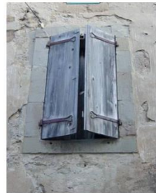
Pentures terminées en forme de coeur (rue du Presbytère)
