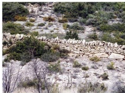
Muret de pierre sèche sur l'Alaric
