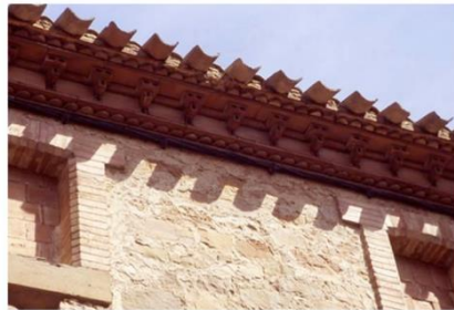
Corniche de toiture bâtie en briques cuites creuses et en carreaux festonnés (2, rue des Monts Lauriers)
