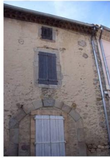
Hiérarchie des ouvertures Enduit ancien à la chaux (2, place de l'Anc. Mairie)
