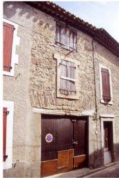
Cave avec linteau en bois soulagé par un arc de décharge (6, rue de la Fontaine)
