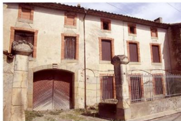
Cave avec arc surbaissé (31, rue du Poutil)
