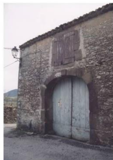
Cave en maçonnerie apparente non enduite. Porche avec "arc en anse de panier", surmonté d'une portailière (Réqui)
