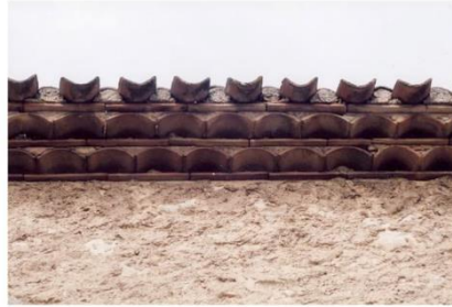
Génoise avec lits intercalaires de carreaux (hameau de Rèqui)
