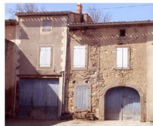
Cave avec arc en anse de panier (vue depuis le n°6 rue des Monts Lauriers)
