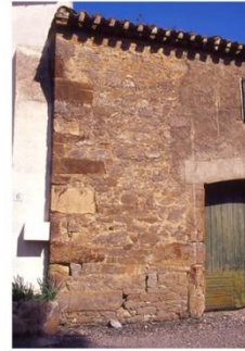
Chaîne d'angle en pierres taillées (6, allée des Acacias)
