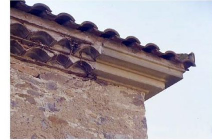
Traitement de l'angle de la génoise par une pierre moulurée (ancienne cave du château Niernans)
