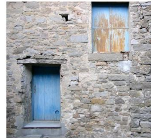
Appareillage irrégulier en moellons tout venant (allée des Acacias)
