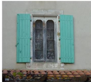
Moustiquaires fixés sur cadres ouvragés (8, rue du Presbytère)
