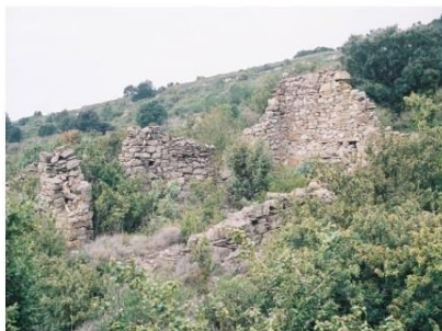
Bergerie en ruine sur l'Alaric
