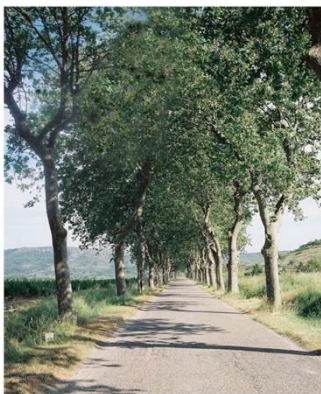
L'alignement de platane de la RD57
