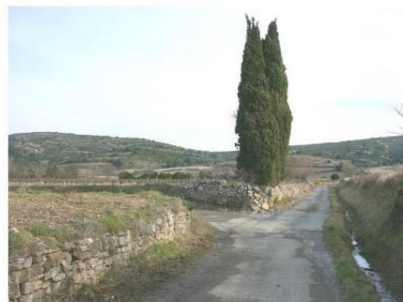
Murets de soutènement en pierre sèche (chemin de Hayches) et vieux cyprès
