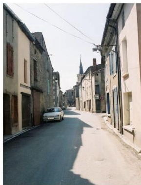
Avenue de Malbec
