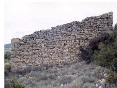
La bergerie en ruine de Gabart
