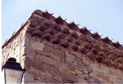
Génoise à trois rangs. Tuiles "courantes" saillantes (12, rue des Monts Lauriers)
