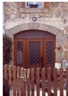
Arc surbaissé, composé de claveaux ondulants (1884) (5, place de l'Aire Verte)
