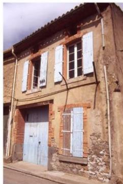
Cave avec profilé métallique. Entourage d'ouverture en briques cuites (35, rue du Poutil)
