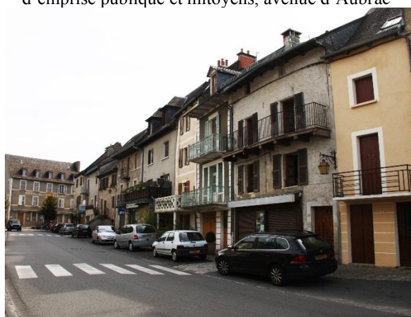
Bâtiments avec mixité de fonction implantés en limite d'emprise publique et mitoyens, avenue d'Aubrac
