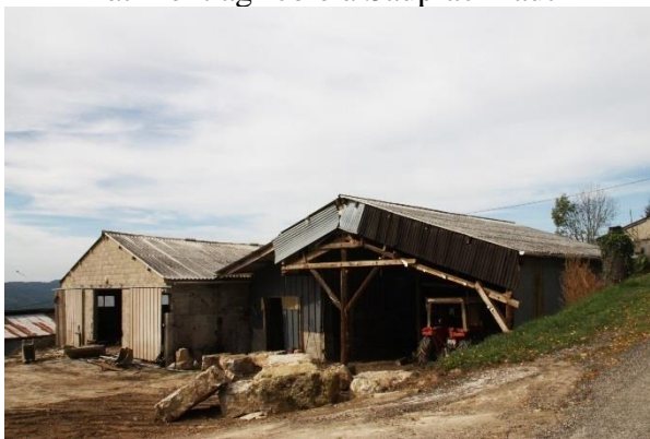
Bâtiment agricole à Saupiac-Haut
