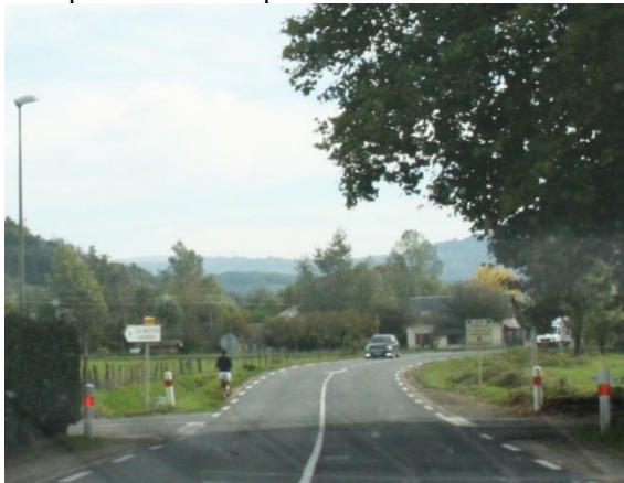
Entrée sur Saint-Côme-d'Olt via la D 987 depuis Espalion : les accotements ne sont pas aménagés pour permettre des déplacements doux sécurisés
