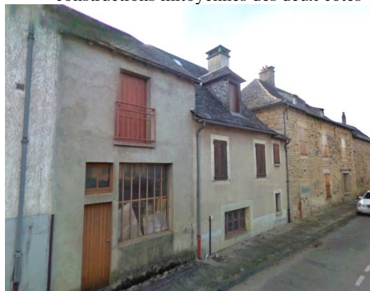
Faubourg le long de l'avenue d'Espalion : constructions mitoyennes des deux côtés
