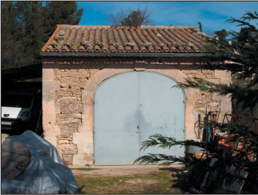
Ancienne remise ou grange dont l'entrée est en pierre taillée de plein cintre.
