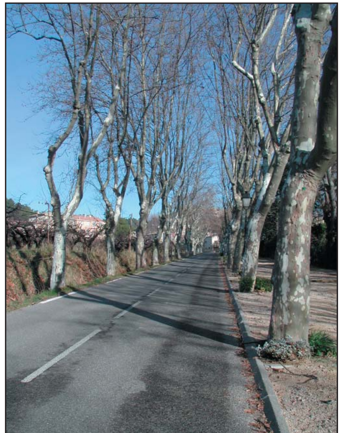
Un double alignement de platanes bordent la RD 68 et annonce l'arrivée sur le centre ancien.
