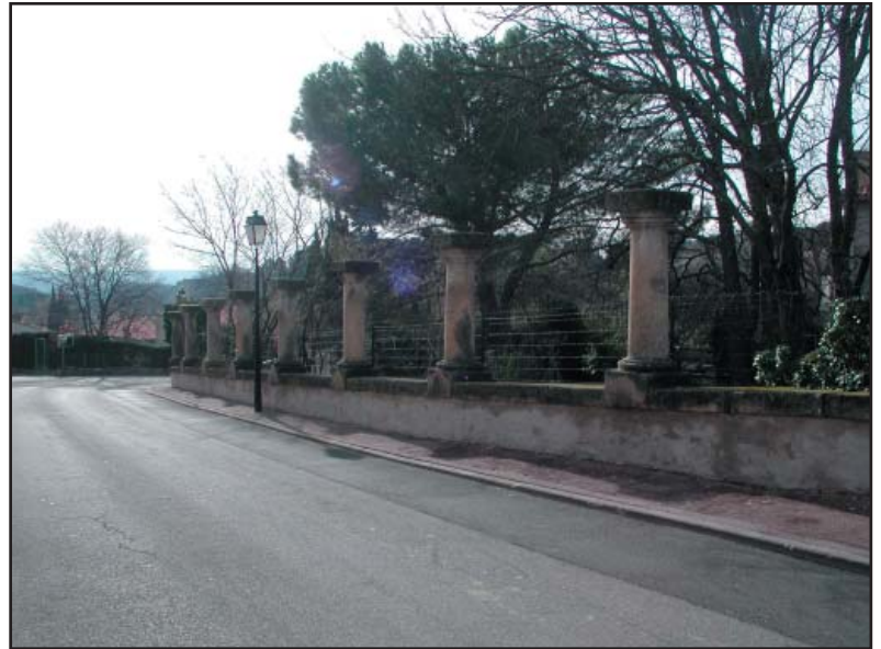
Les vestiges de l'enceinte de l'ancien château
