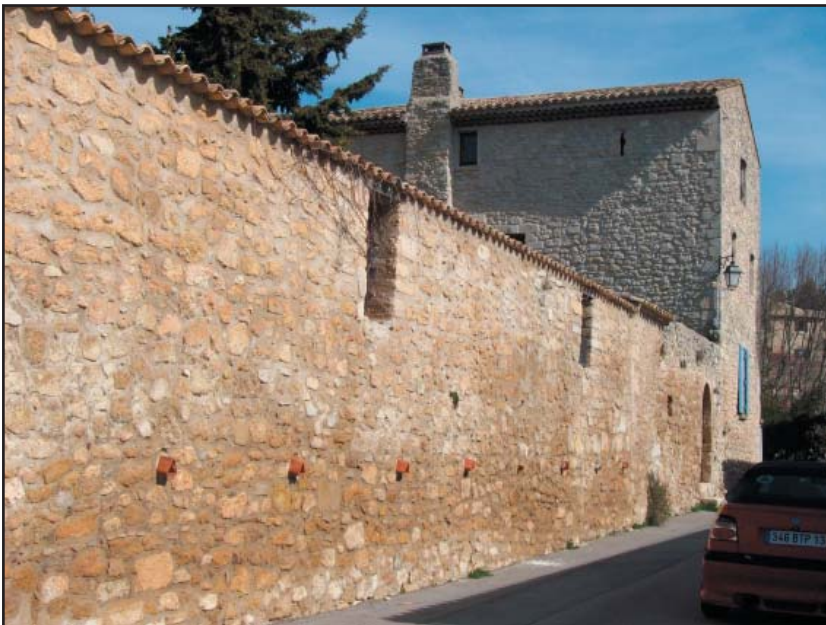
Élément bâti patrimonial notable situé à l'entrée Ouest
