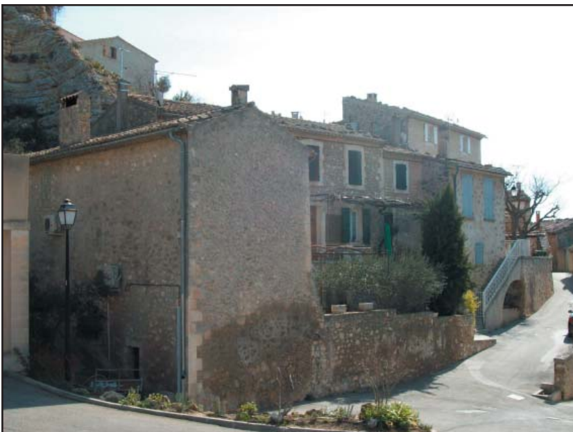
Ensemble bâti en limite Ouest du village
