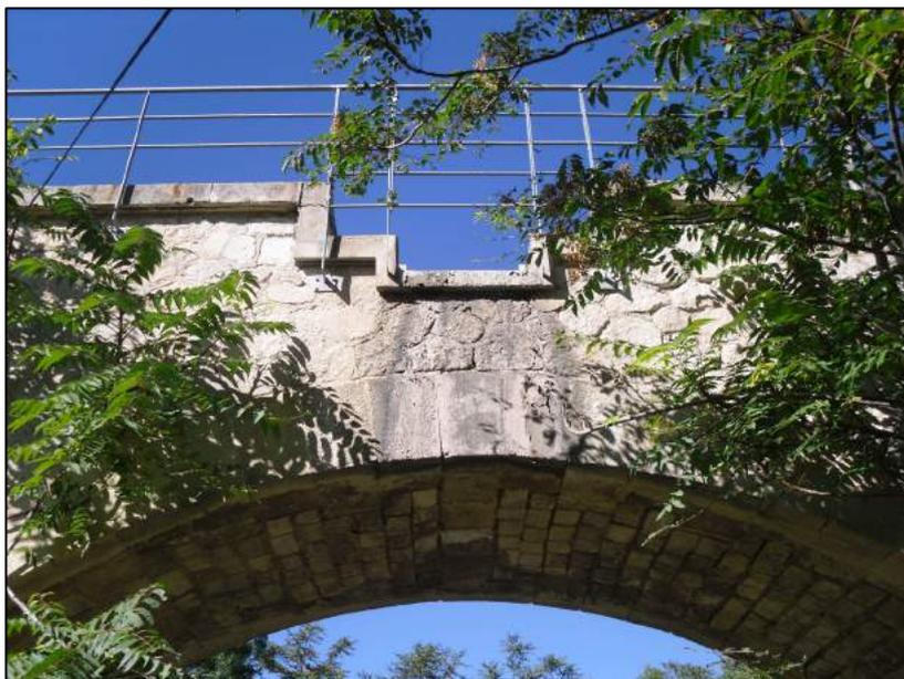
*PHOTO 3 : DEVERSOIR DE SECURITE SUR L'AQUADUC DE MANVILLE (COTE AVAL)*
