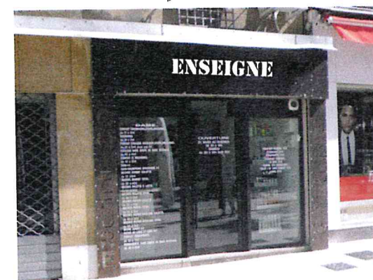
Enseigne bandeau en tôle découpée en creux
