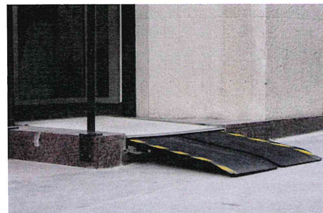
Rampe automatique encastrable dans le seuil de porte (dépliée sur le domaine public)
