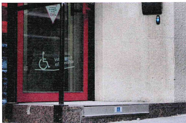
Rampe automatique encastrable dans le seuil de porte (repliée)
