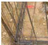
Noeud de chaînage - Continuité mécanique
