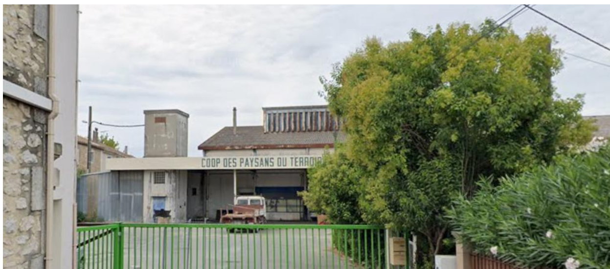
Vue sur le bâtiment désaffecté depuis le chemin de Ranjarde au nord © Google maps
