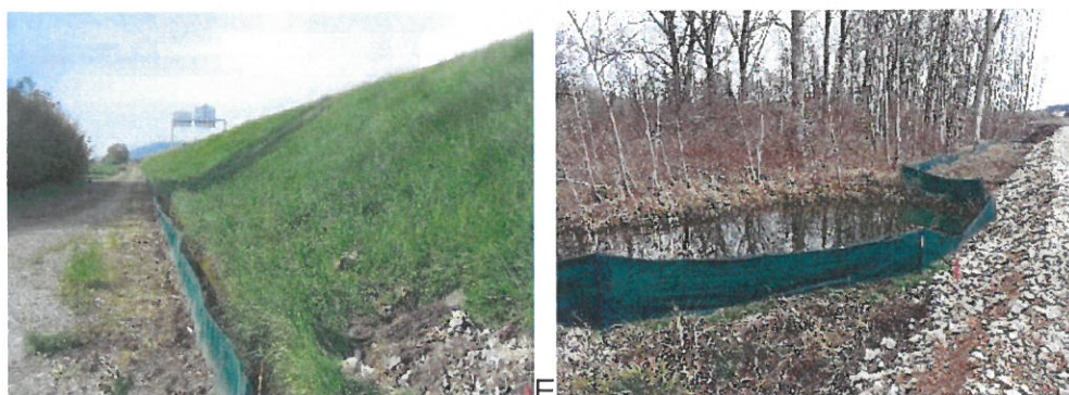
Illustration 138. Exemple de clôture spécifiques pour les batraciens
