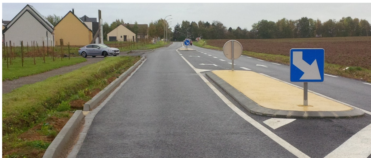
Vue de la Maslière depuis la RD220 - Amenageo - Octobre 2017
