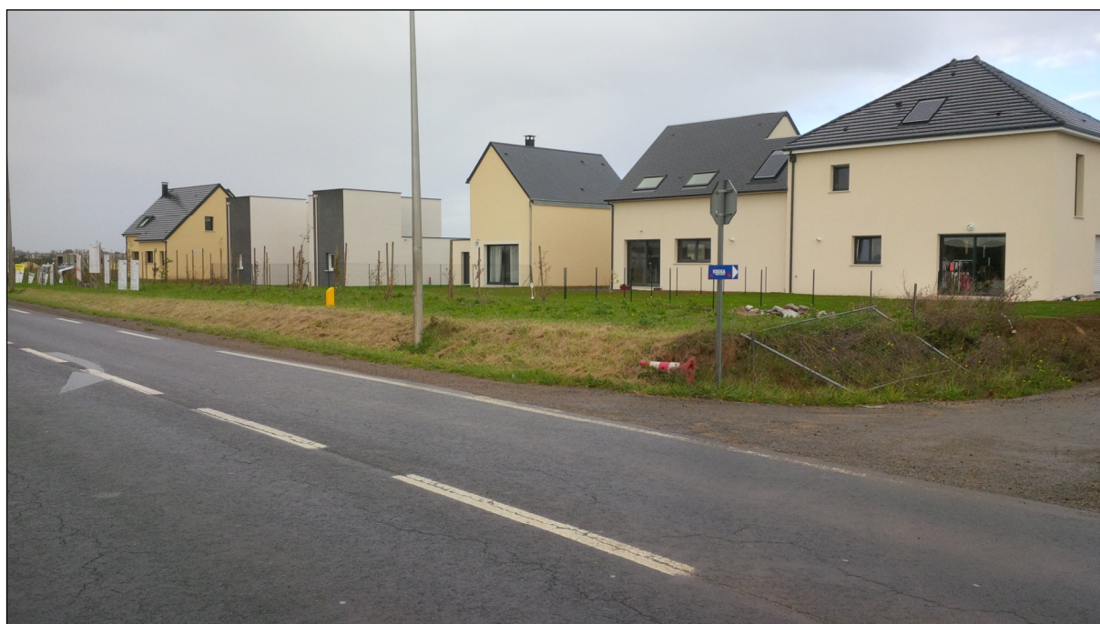
Photos des constructions le long de la Maslière - Octobre 2017
