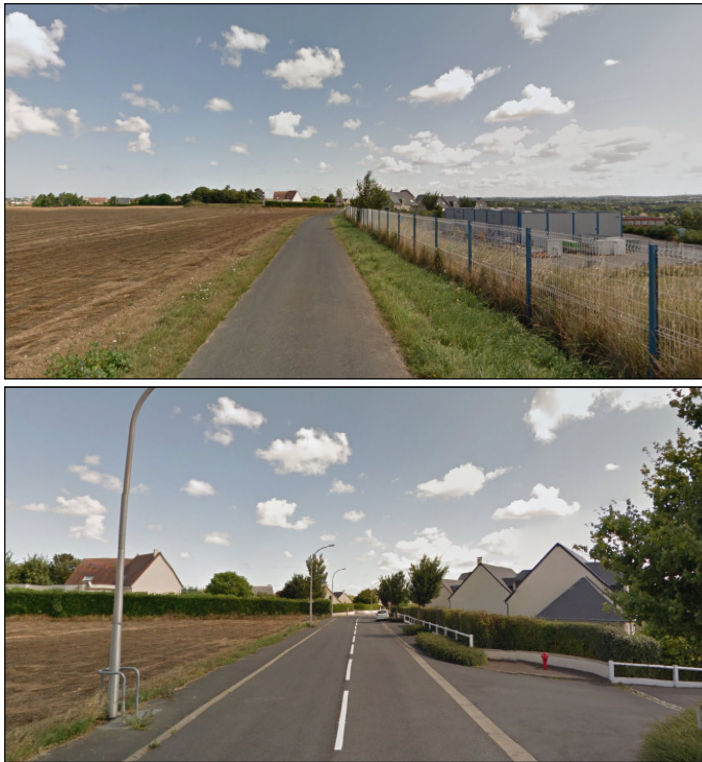
Vues du chemin des crêtes - Google maps - Juin 2016
