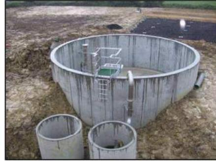
Située au nord du quartier du Lieu Baron et au nord de l'autoroute A13, la nouvelle station d'épuration permettra de traiter 522 m<sup>3</sup> d'eaux usées par jour, ce qui correspond à une population de 3 000 EH. La voie d'accès débouche sur le chemin de l'Enclave. Le principe de fonctionnement de la station d'épuration est basé sur le procédé d'aération prolongée des eaux usées et d'activation des boues.
