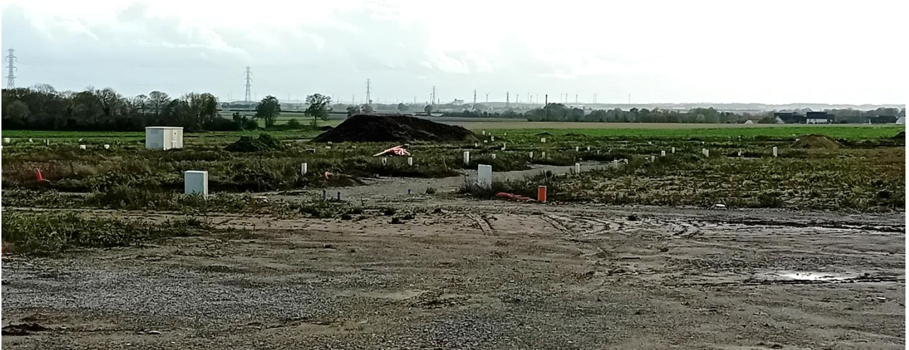
Viabilisation en cours du Clos Cuverville (zone 1AUa) (photo 15/11/2023)
