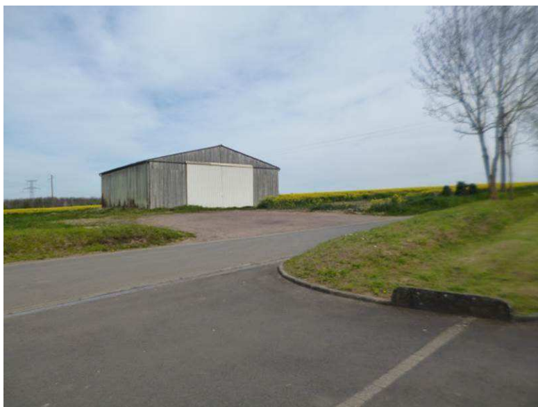
Hangar de stockage d'Alain BARATTE
