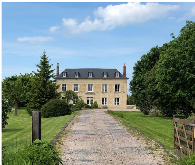
Exemple de maison de maître dans la commune de Goustranville
