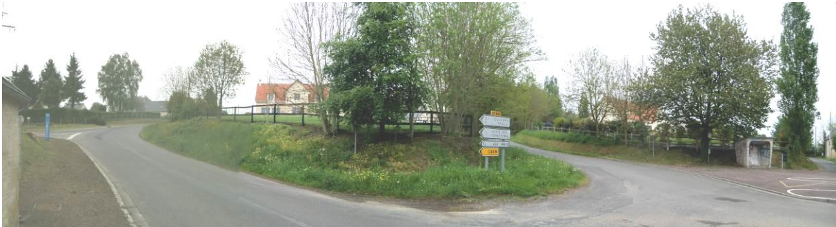
Carrefour des RD158 et RD158B - Discontinuité du cheminement doux entre l'arrêt de bus (à droite) et le trottoir allant vers le Nord (à gauche), source : Planis
