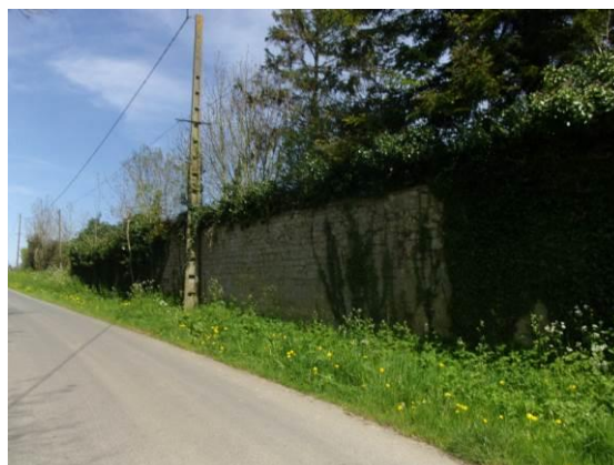
Mur en pierre
