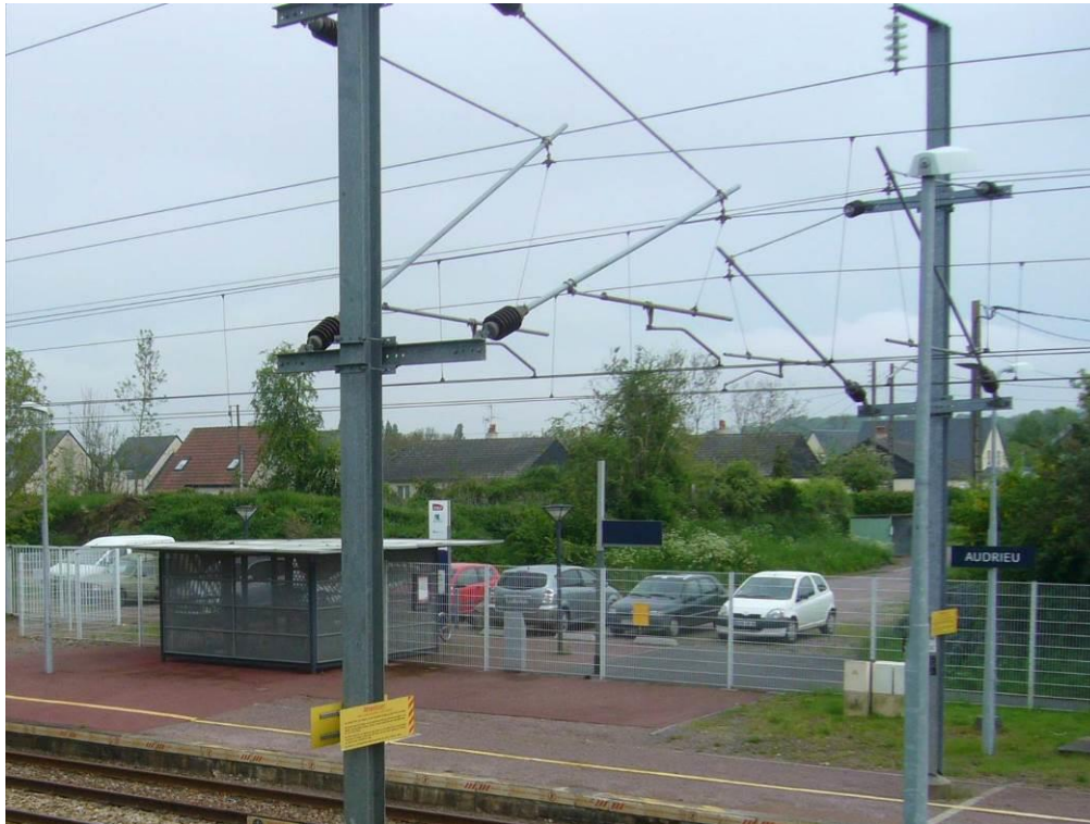
Box vélos et stationnement voitures à la halte ferroviaire d'Audrieu, source : Planis
