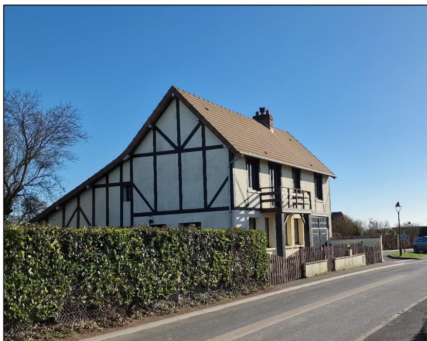
Maison construite dans le style néo-normand dans le centre-bourg de Petiville (source : photographie de terrain)
