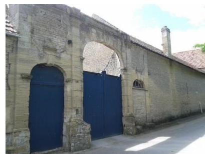
Bâti remarquable : double porche
