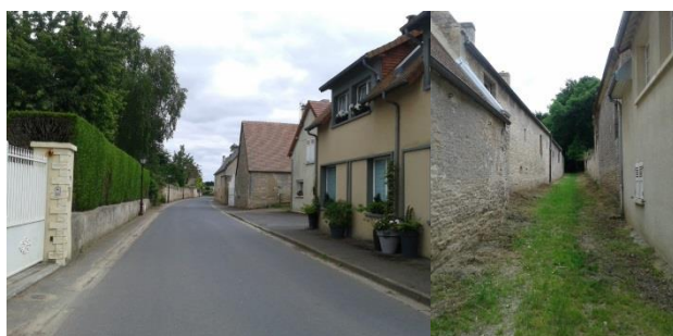
Allure urbaine de la voie
