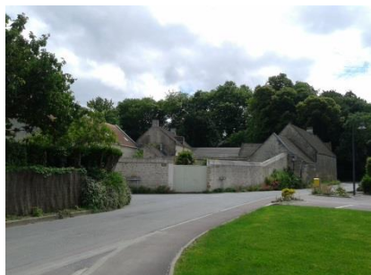
Bâti ancien (ferme du bourg)
