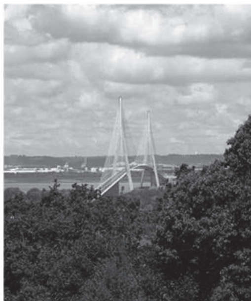
Le Pont de Normandie, depuis le site
