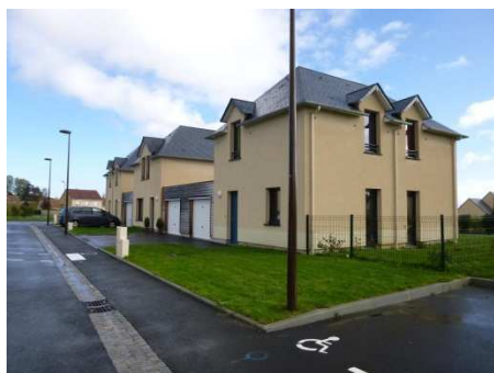
Opération de 11 logements
