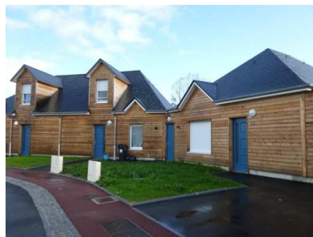
Opération de 6 logements
