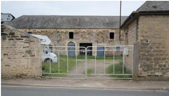
Le bourg bâtiment de stockage (n°5) susceptible de ne plus être utilisé
