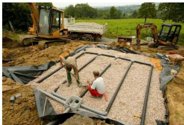
La mise en place d'une station - Source : www.copadoz.fr
