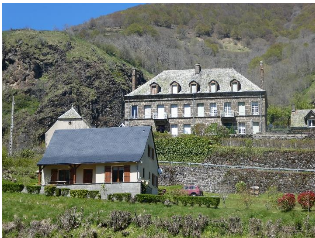
Maison de maître et pavillon au premier plan
