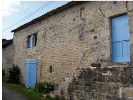
Maison et dépendance agricole (parcelle 900 et 857), rue du Puits Piquet
