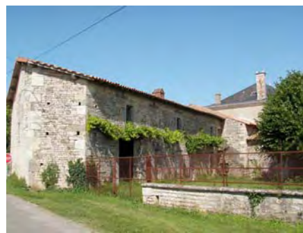
Maison de maître, dépendances (parcelle 283) et longère (parcelle 285), rue du Peu Magnet. La propriété s'accompagne de 2 jardins : l'un sur la façade sud du bâtiment ; le second occupant les parcelles 665 et 666.
