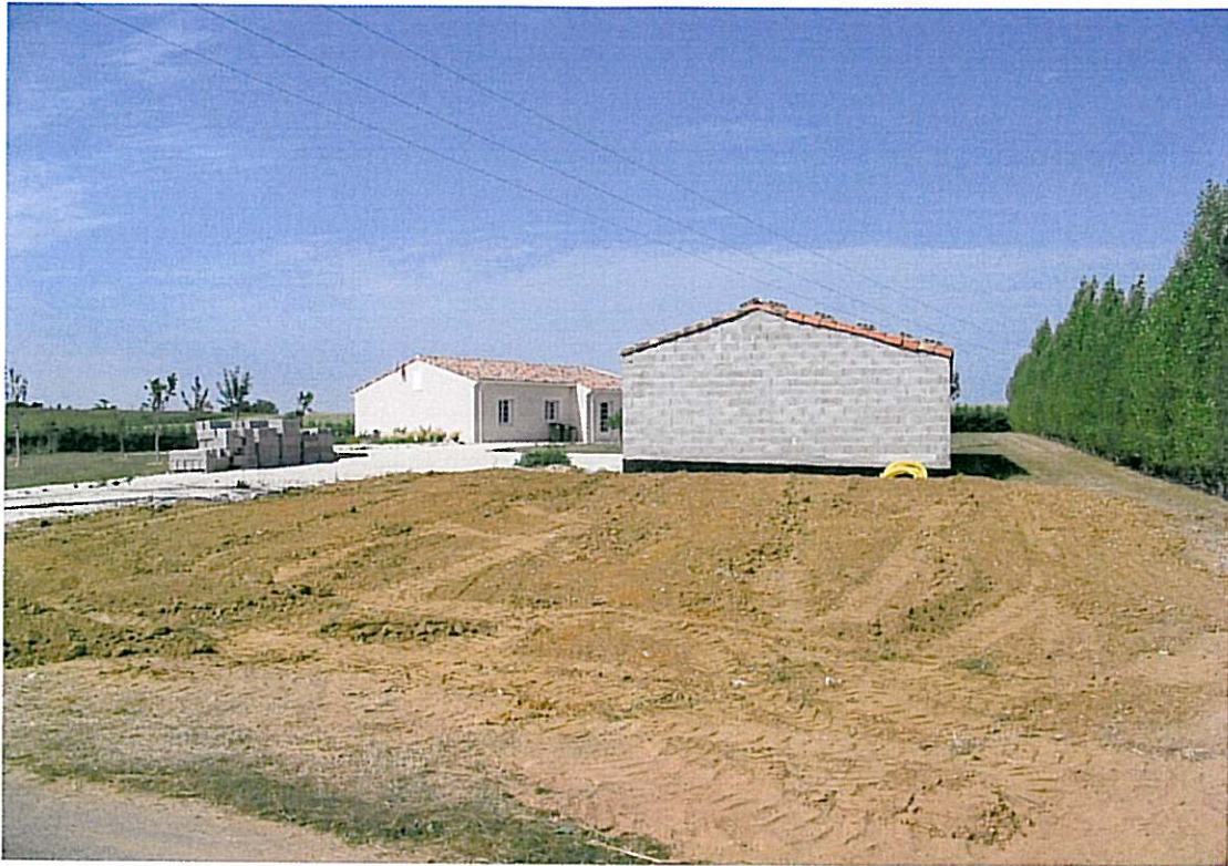
La construction récente trop consommatrice d'espaces et le « bâtiment d'exploitation ».
