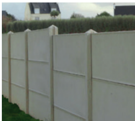
Plaques lisses béton moulé
