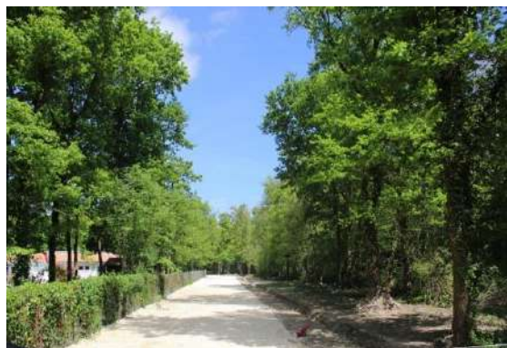
Fief de la Roche : ouverture d'une voie de desserte annonçant la construction de nouvelle habitations
