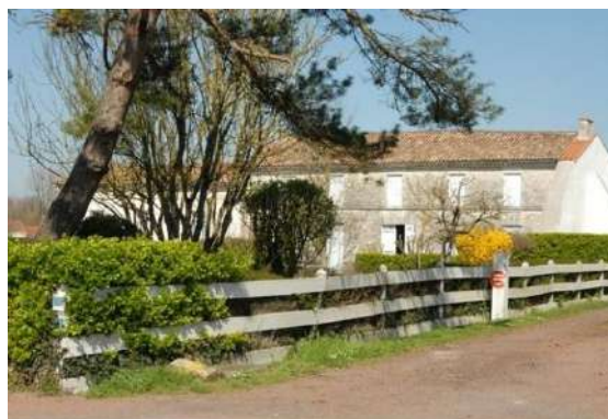
Le Logis de La Roche (dit ancien prieuré)
