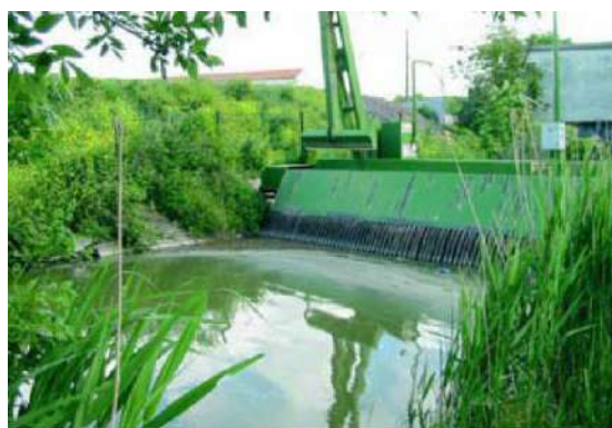
Station de pompage/filtrage construite en 1966
