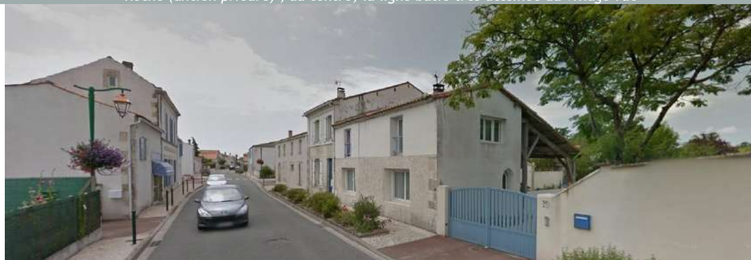
La rue du centre : Bâti vernaculaire avec alignement des façades sur rue et jardins clos
