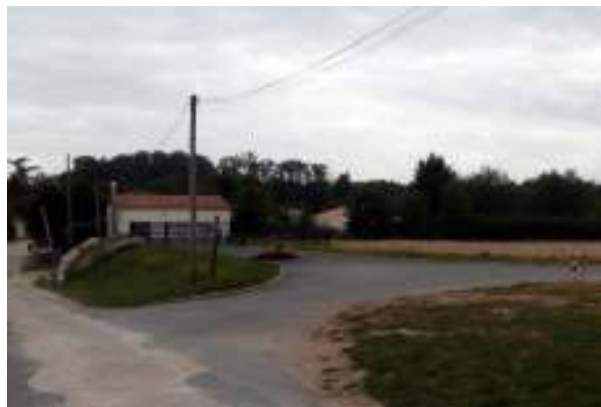
Chaufferie Bois Energie de la commune
