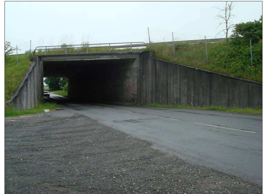
Passage de la RD129 sous l'autoroute A10
