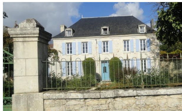
Maison de maître dans le hameau de la Basse Vergnée
