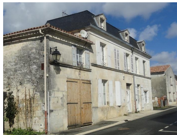
Maison de maître dans le bourg (toiture en ardoises percée de 3 lucarnes)
