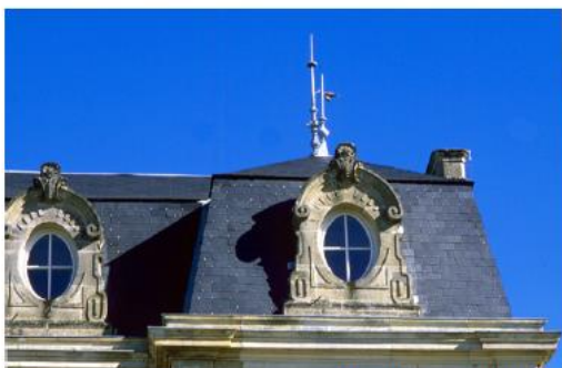
Toit en ardoises et lucarnes
