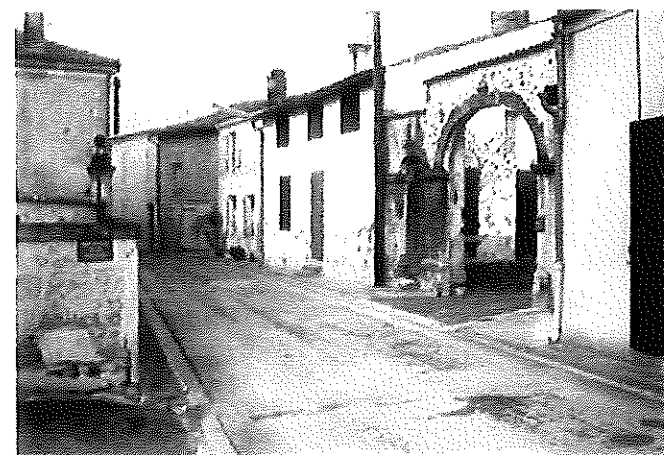
Portail assurant la continuité bâtie dans la rue Basse
