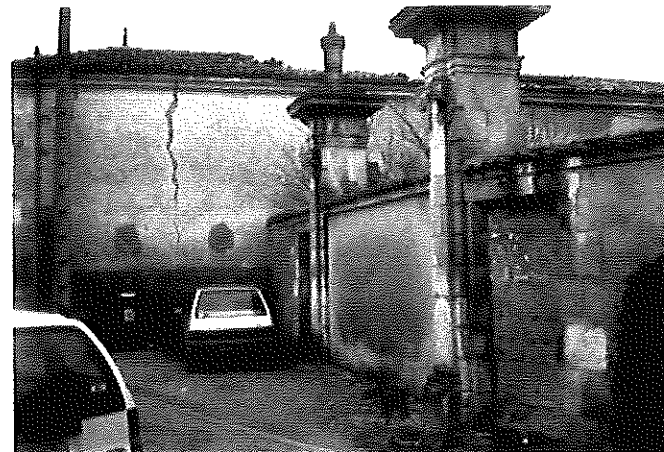
Piles d'un ancien portail aujourd'hui condamné
