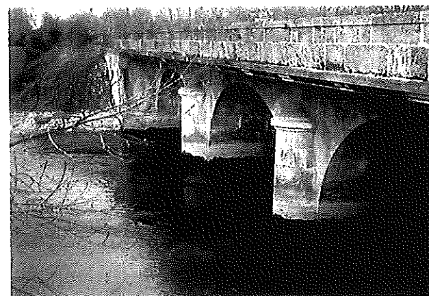
Le pont enjambant le Marais de la Boutonne et rejoignant Saint-Jean-d'Angély
