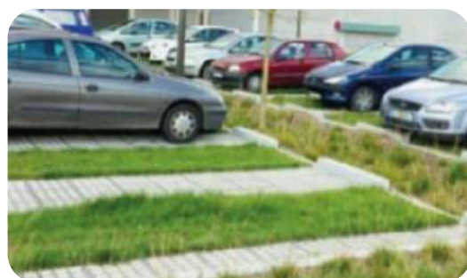
Noue végétalisée avec infiltration gravitaire du ruissellement
