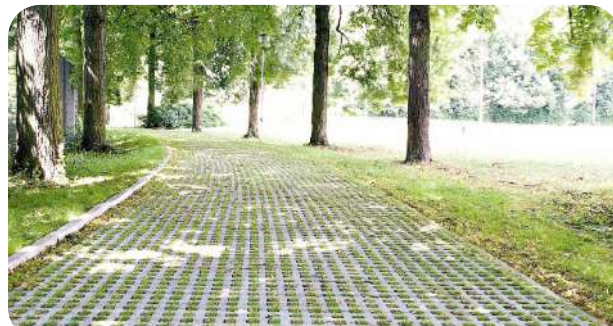
Revêtement de circulation douce semi-perméable
