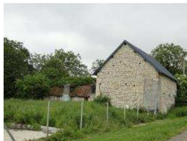
Habitat à rénover
