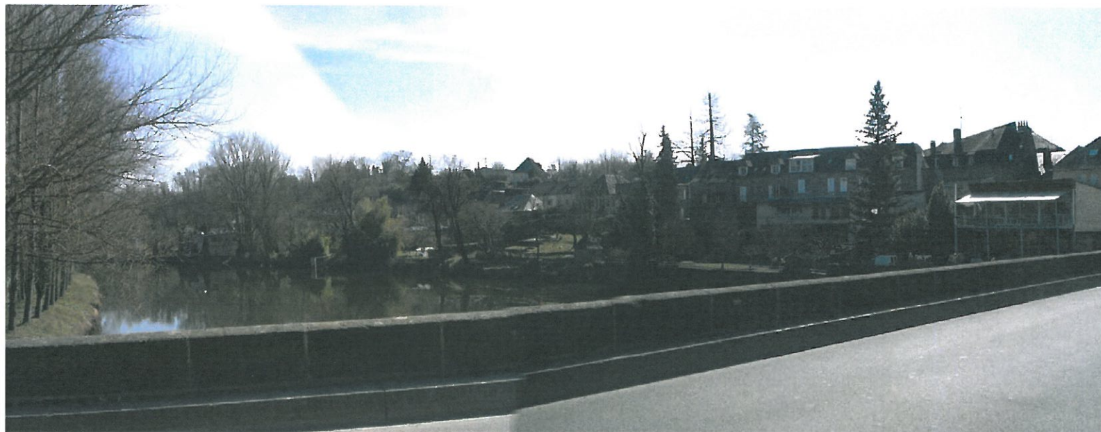
Vue du site Natura 2000 et de la berge communale aux abords du bourg de Larche et du pont Barbazan
