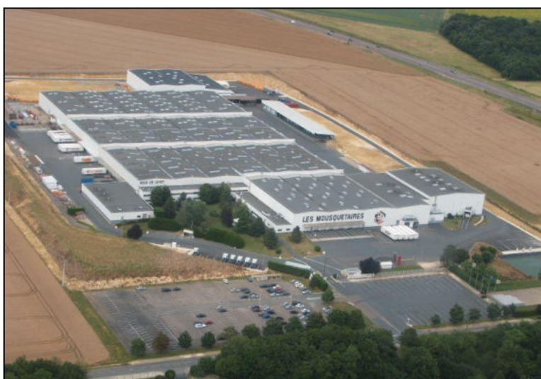
Figure 85: Plateforme logistique à Levet
