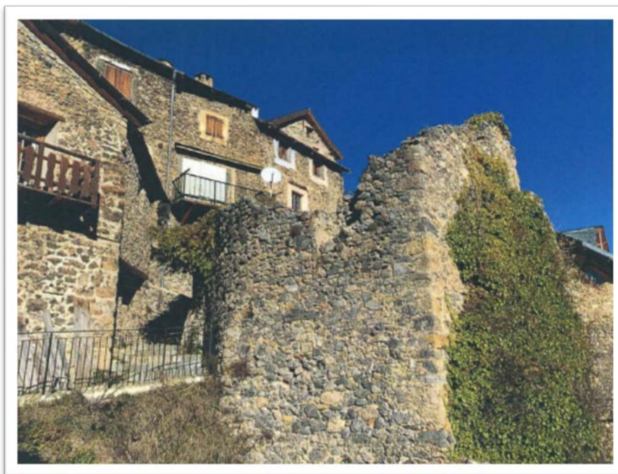
Photographie du bâtiment en ruine sis sur la parcelle D 238 se situant dans la continuité du cœur du village de Roubion
