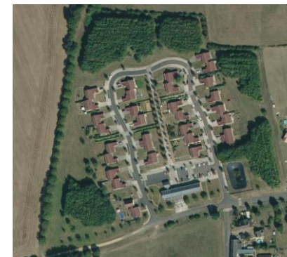
Quartier de logements locatifs sociaux de Beffes
