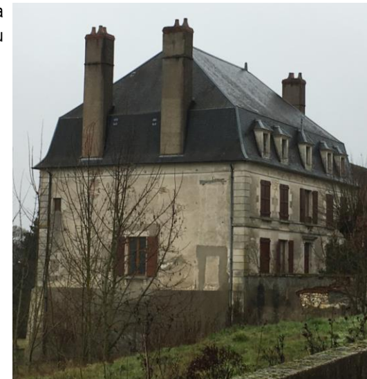
Maison de maître à Herry en surplomb du canal
