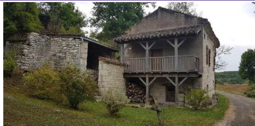
Ferme ancienne en bordure de voie dont les abords sont simplement marqués par quelques plantations d'arbustes.
