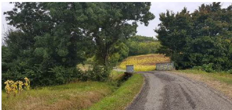
Des ponts ponctuent discrètement les paysages des vallées
