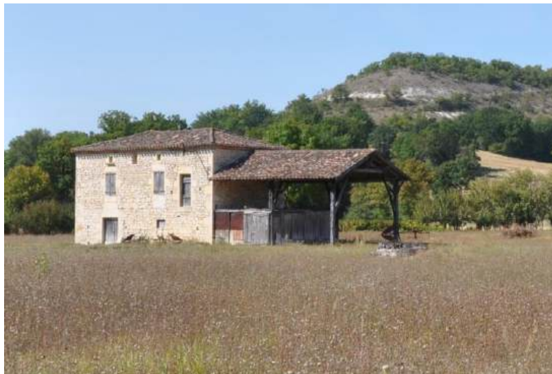
Ferme à l'architecture vernaculaire du Quercy Blanc caractérisée par un appareil soigné des moellons blancs laissés apparents, et un toit à faible pente à 4 pans fait de tuiles canal.
