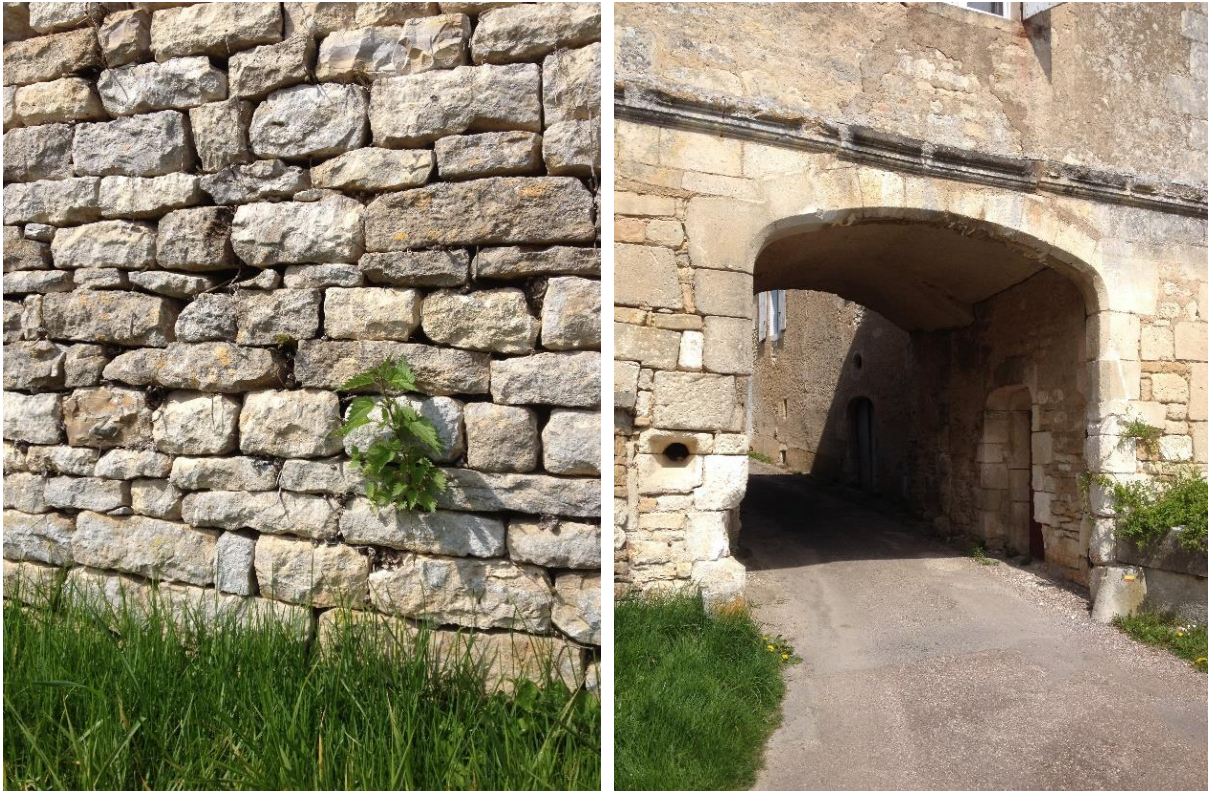
Murs en pierre calcaire à joints vifs, appareillage de voûte et joints beurrés
