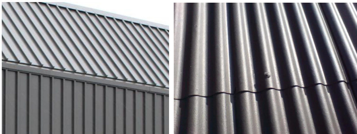
Toiture en bac acier et tôle en fibre ciment
