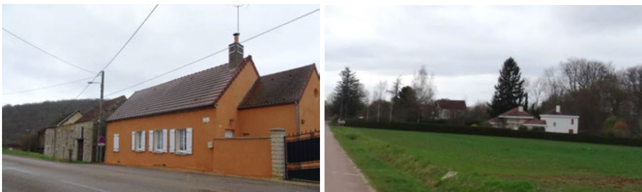
Photographie 52 – Nouvelles constructions dont l'architecture et/ou les revêtements dénotent avec le bâti existant. A gauche, Crai (commune de Chamoux), à droite le Bois du Fourneau à Merry-sur-Yonne
