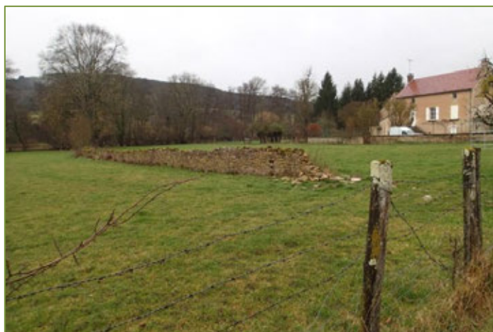
Photographie 29 – Muret de pierre (VAULT-DE-LUGNY)
