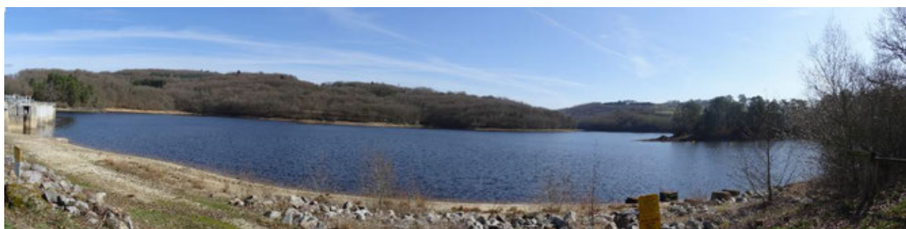
Photographie 174 – Lac du Crescent, barrage hydro-électrique
