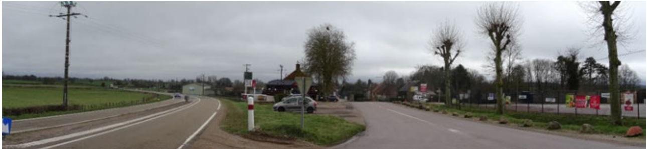
Photographie 111 – Entrée de ville dégradée à Cussy-les-Forges
