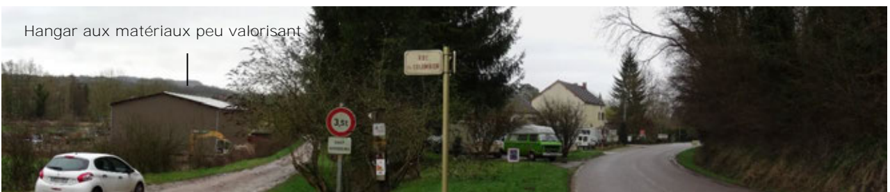
Photographie 152 – Entrée de ville en cours de dévalorisation à Saint-Père
