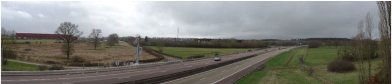
Photographie 116 – Autoroute A6
