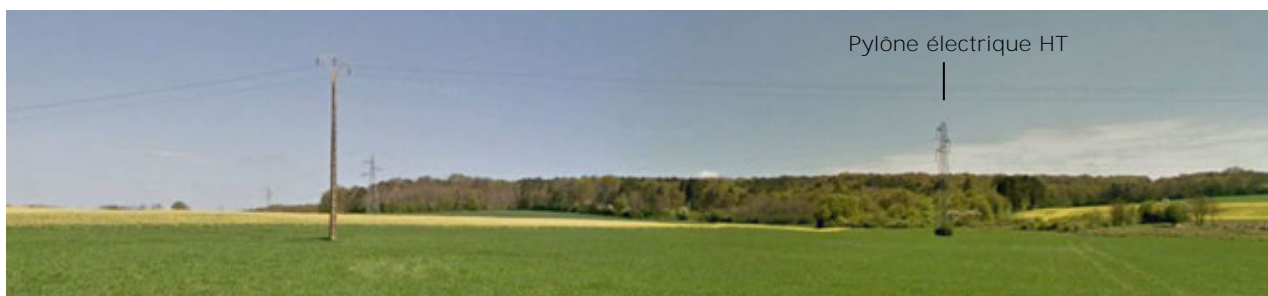
Photographie 61 – Lignes électriques HT du plateau de Noyers (Source : Google Earth Pro, mai 2013)
