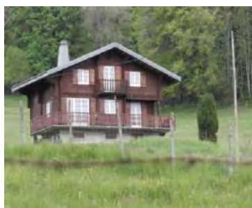
Corbel à proximité des Egaux- Chalet des années 1970'
