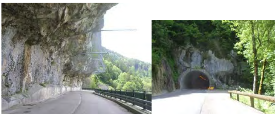
Route des gorges du Guiers Vif, creusée dans la roche, en surplomb, avec des filets de protection, et le tunnel du Frou
