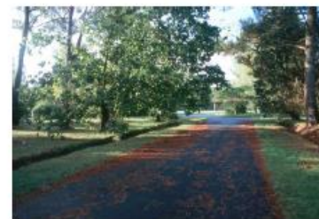
voirie et fossés latéraux
